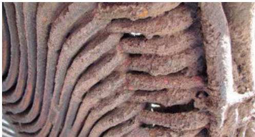
Figura 5. Fotografía mostrando la condición de ingreso del motor.
